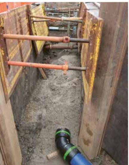
In den Schächten werden auch die Trinkwasserleitungen (vorn im Bild) verlegt.
